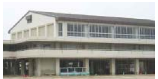
岡山市立宇野小学校の体育館
